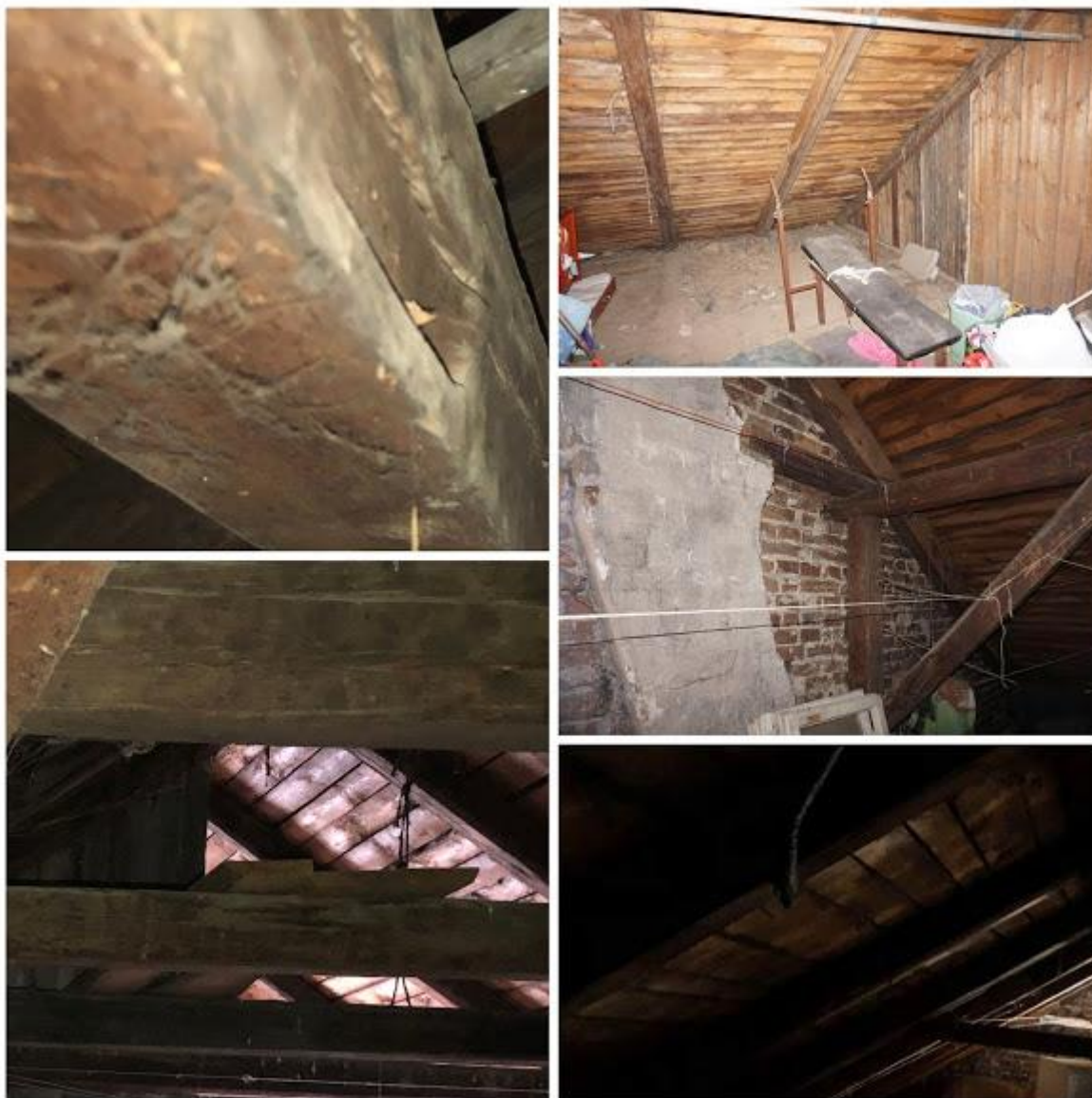
Fot. 24-28. Widok więźby dachowej i deskowania. Ślady zagrzybienia i wysoleń po zawilgoceniach, nieliczne żerowiska spuszczela pospolitego ( Hylotrupes bajulus ).
