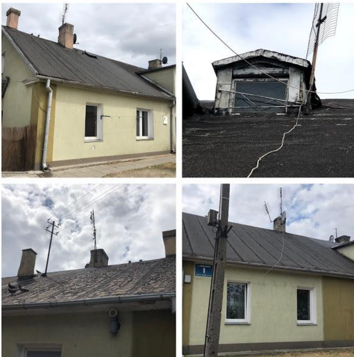
Fot. 1-4. Pokrycie dachu – papa jest w złym stanie, stwarza zagrożenie przecieków wód opadowych.
