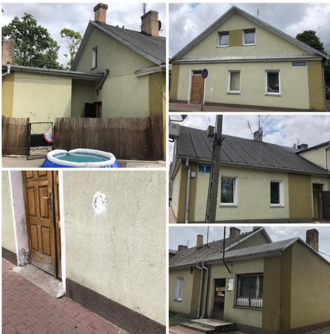
Fot. 5-9. Elewacje budynku po ociepleniu styropianem z wykończeniem tynkiem mineralnym – drobne uszkodzenia - stan dobry.
