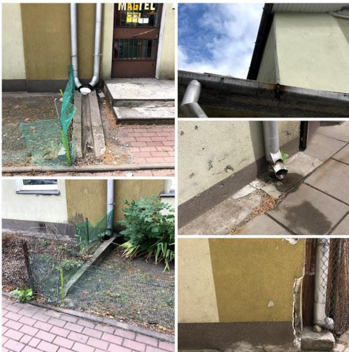
Fot. 10-14. Widoczne uszkodzenia rynien, rur spustowych, rzygaczy, odprowadzających wody opadowe na chodniki bezpośrednio przy cokole lub za pomocą betonowych koryt ściekowych.
