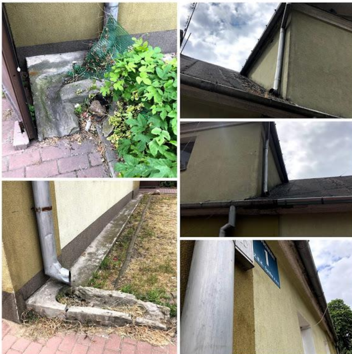
Fot. 15-19. Widoczne uszkodzenia rynien, rur spustowych, rzygaczy, odprowadzających wody opadowe na chodniki bezpośrednio przy cokole lub za pomocą betonowych koryt ściekowych.
