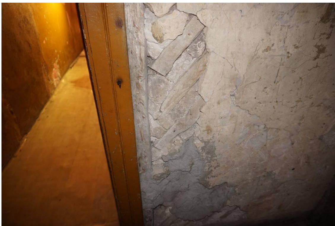
Fot. 32. Uszkodzenie ściany spowodowane zawilgoceniem, odspojenie tynku.
