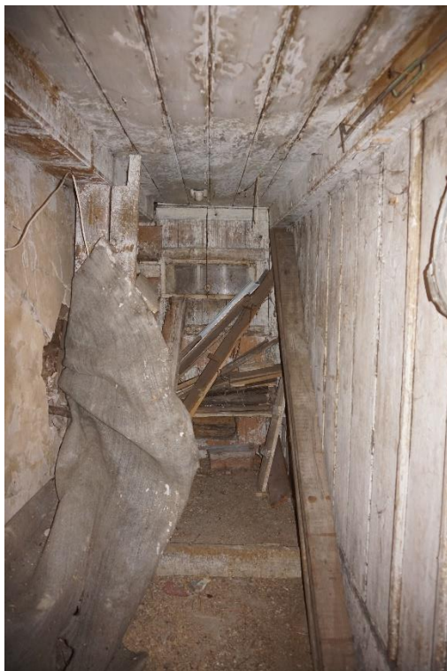
Fot. 31. Uszkodzenie ściany spowodowane zawilgoceniem, odspojenie tynku, ślady zawilgocenia desek sufitu.
