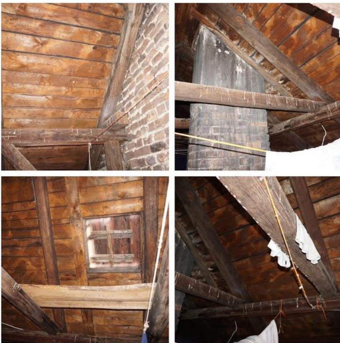
Fot. 20-23. Widok więźby dachowej i deskowania. Ślady zagrzybienia i wysoleń po zawilgoceniach w sąsiedztwie komina widoczne zasuszone fragmenty grzybni grzyba domowego ( Serpula lacrymans ), nieliczne żerowiska spuszczela pospolitego ( Hylotrupes bajulus ).
